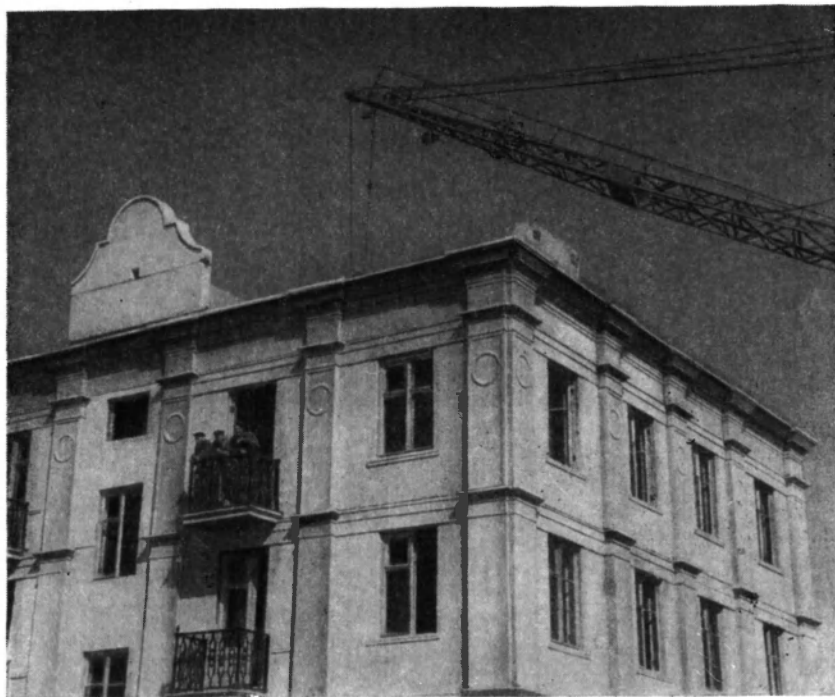
Монтаж крупнопанельного дома (Магнитогорск. Арх. Э. Нестерова, 1951 г.)
