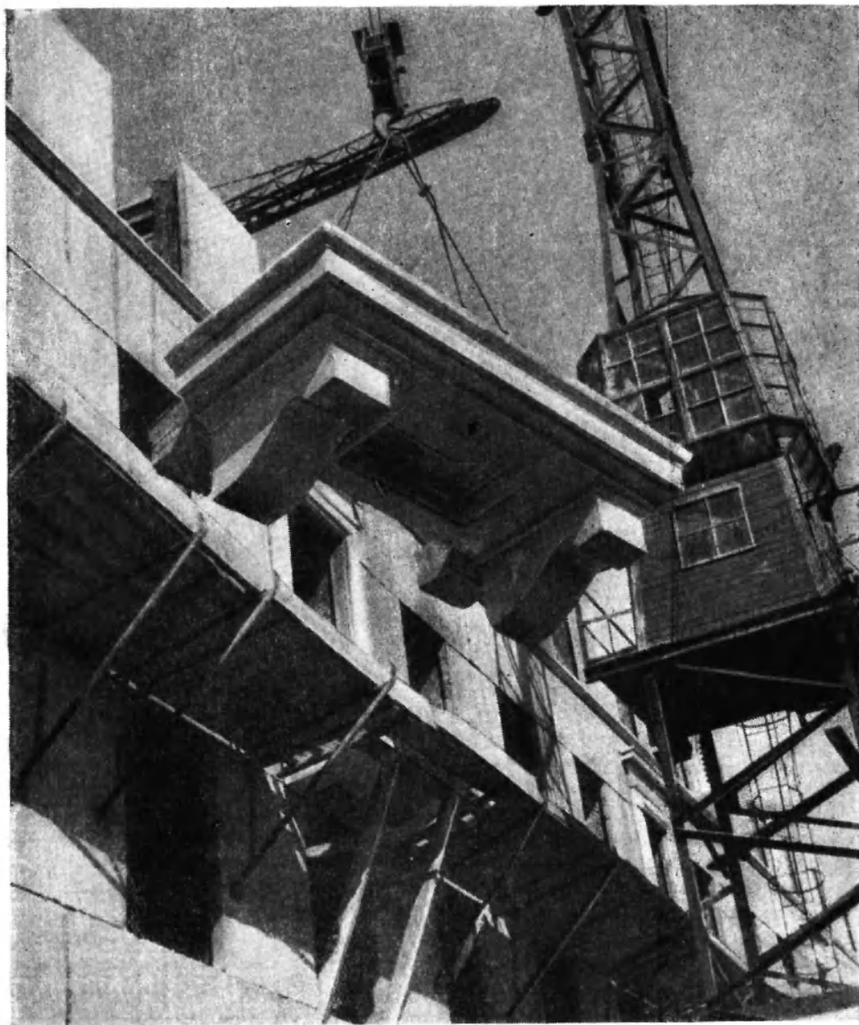
Монтаж балкона заводского изготовления с декоративными кронштейнами
