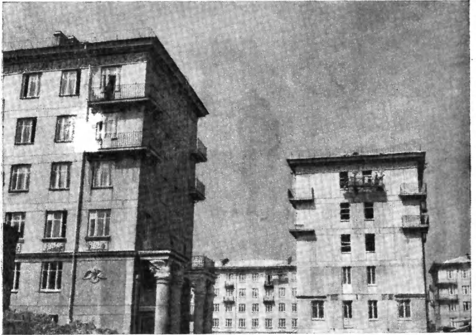
Двухрядная разрезка стены на блоки (Ленинград. Дом на проспекте Сталина. Архитекторы Б. Журавлев и В. Васильковский)
