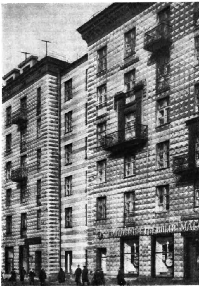
Крупные блоки в виде бриллиантовой кладки (Москва. Дом на Б. Полянке. Архитекторы А. Бухов и Б. Блохин)
