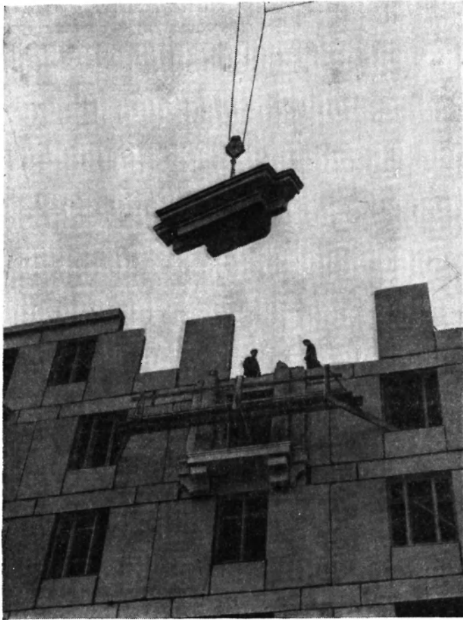
Монтаж крупноблочного дома (Ленинград, 1954 г.)
