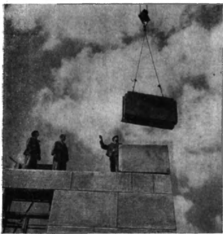
Монтаж стены из крупных блоков
