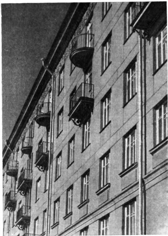
Двухрядная разозка стены на блоки (Ленинград. Дом на проспекте Сталина. Архитекторы Б. Журавлев и В. Васильковский, 1954 г.)
